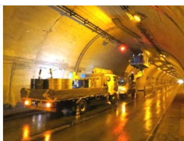
裏込め注入工
