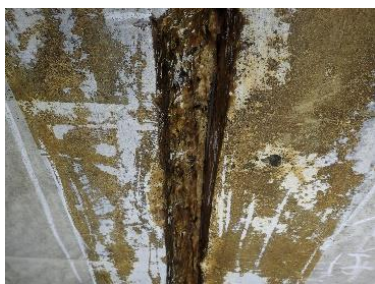
はつり+含浸接着工
