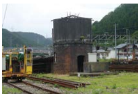
今庄駅給水塔
