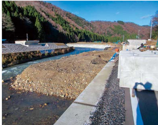
輪中堤整備工事現場
