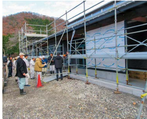
仙山城跡ガイダンス施設建設現場
