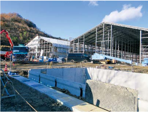
(株)デイリーエッグツチダ南越前農場建設現場
