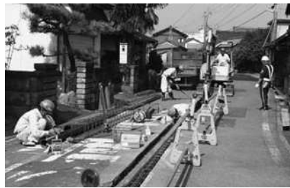
大道地係の融雪工事
