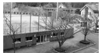
桜橋運動公園野球場
