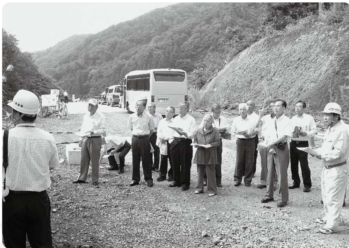
国道 365 号道路改築工事（椿坂トンネル）現地視察（滋賀県）
